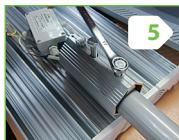
Закрепить светильник на монтируемую опору. Закрутить болты с усилием крутящего момента не более 29 Н/м
