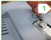
Открутить винт (барашек) на защитной крышке светильника
